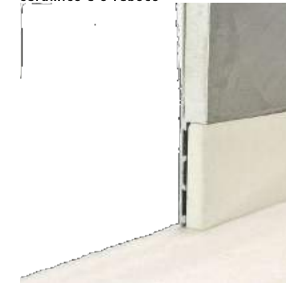
Alheta de Separação entre o cerâmico e o reboco
