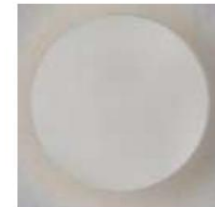
revêtement mural extérieur
